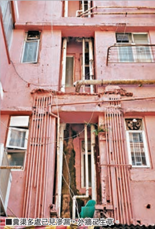
■半開放式的斗形污水渠，多個分支匯入方形聚水盒，有淤塞及液體飛濺的風險。
