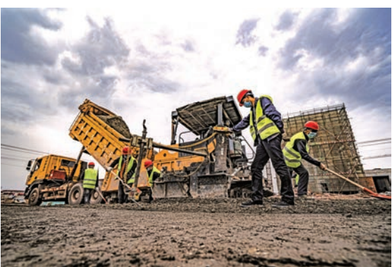
四川成都天府國際機場復工建設熱火朝天。新華社
