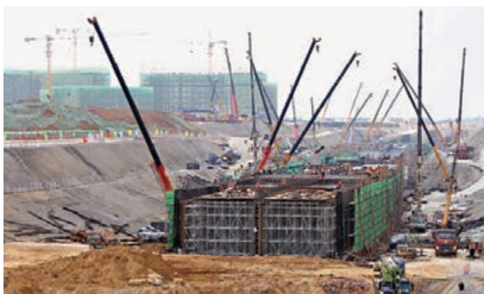
▲東安湖湖底隧道施工現況。香港文匯報記者 李兵 攝
