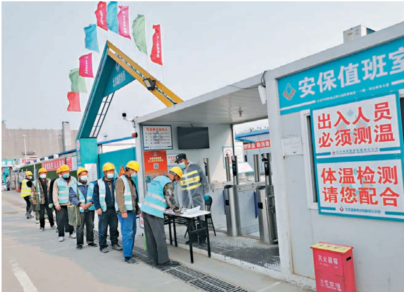
■施工人員排隊進行體溫測量登記。
