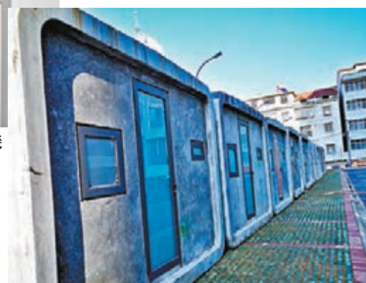
3D打印技術「打印」出的小屋。
