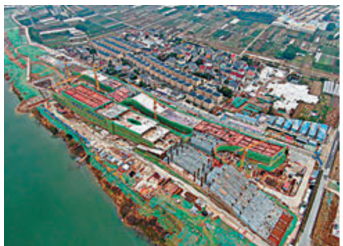
富陽水上運動中心施工現場。組委會官網圖片
