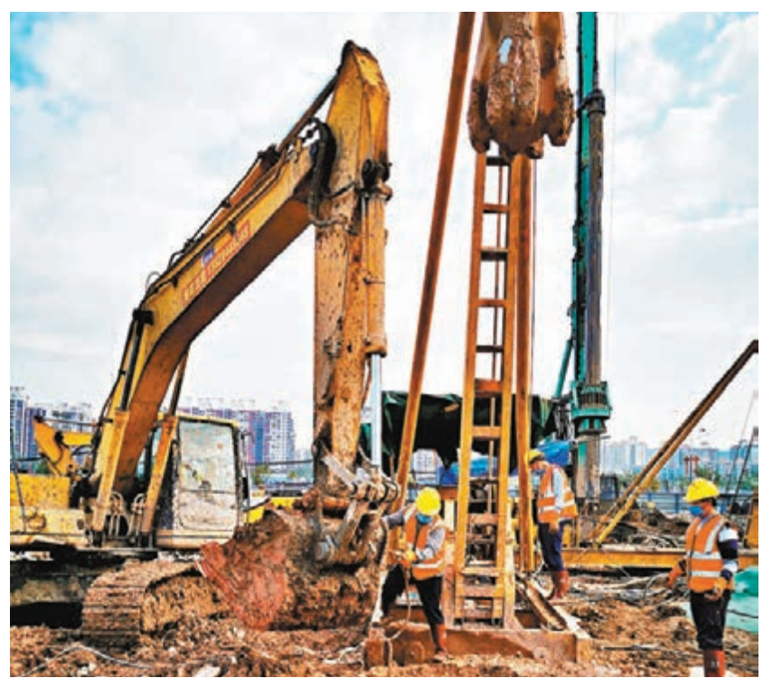
中建三局南方公司設計之都項目在打樁衝孔鑽機作業。受訪者供圖
