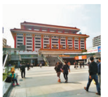
■圖為深圳羅湖口岸邊檢大樓。資料圖片
