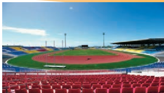
■陝建集團承建的佛得角體育場項目。
