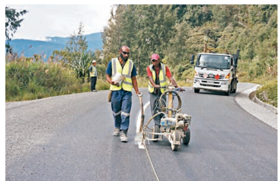
■陝建集團承建的巴布亞新畿內亞Ip公路項目施工，圖為當地工人正在施工。
