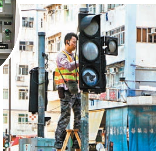
機電署人員昨日忙修理被破壞的交通燈。
