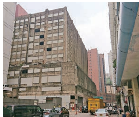
荃灣區工廈下半年在各區跌幅最大。資料圖片
