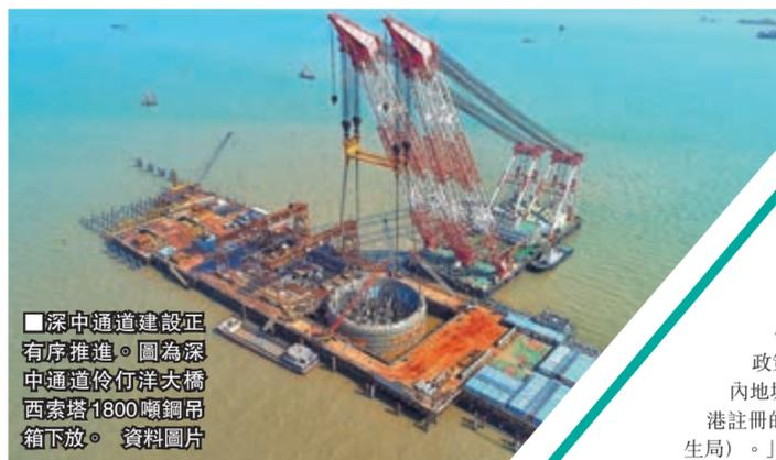
■深中通道建設正有序推進。圖為深中通道伶仃洋大橋西索塔1800噸鋼吊箱下放。資料圖片
