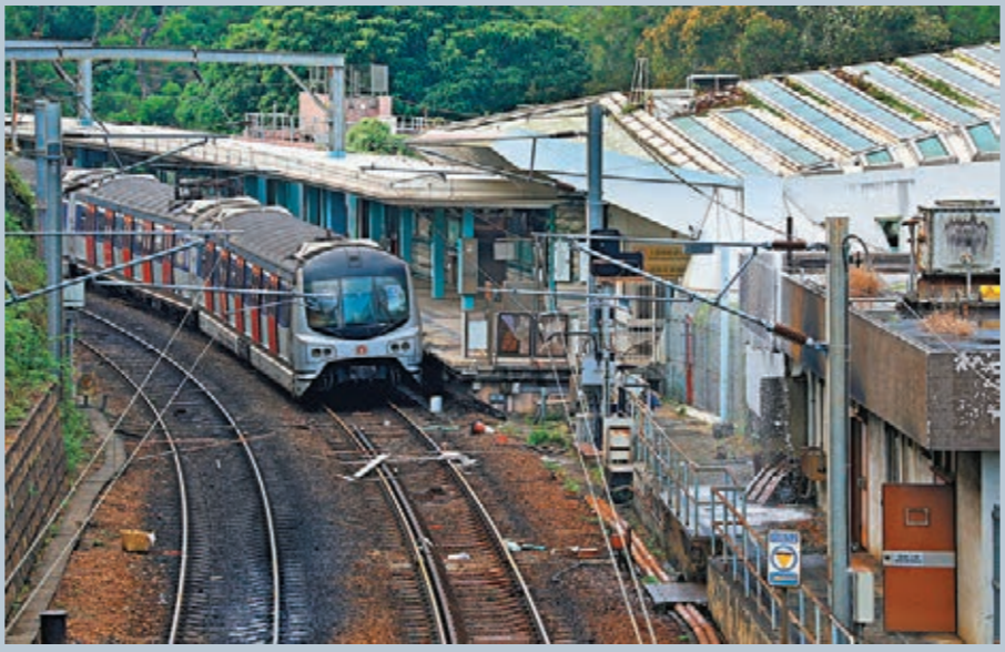
中大橋下的東鐵大學站水管漏水，大量雜物灑落在路軌上。
