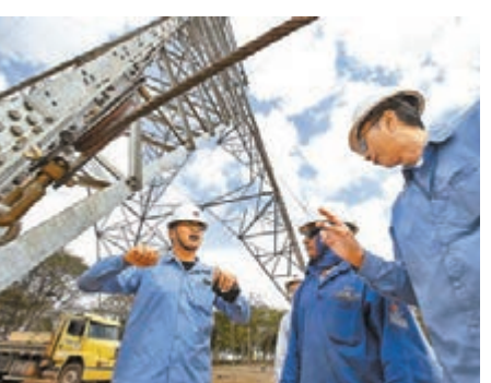
2018年8月7日，巴西美麗山特高壓輸電工程中方現場施工管理負責人（左）在施工现场指導巴方員工。
