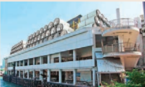
■只要結構允許，水管屋可安置在大廈天台甚至碼頭上方等，而且容易重置。
