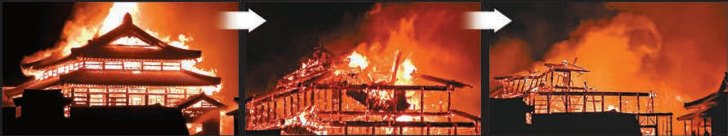
■被稱為「國殿」的首里城正殿在起火時仍可見支架，但隨着火勢增大，支架倒塌。
