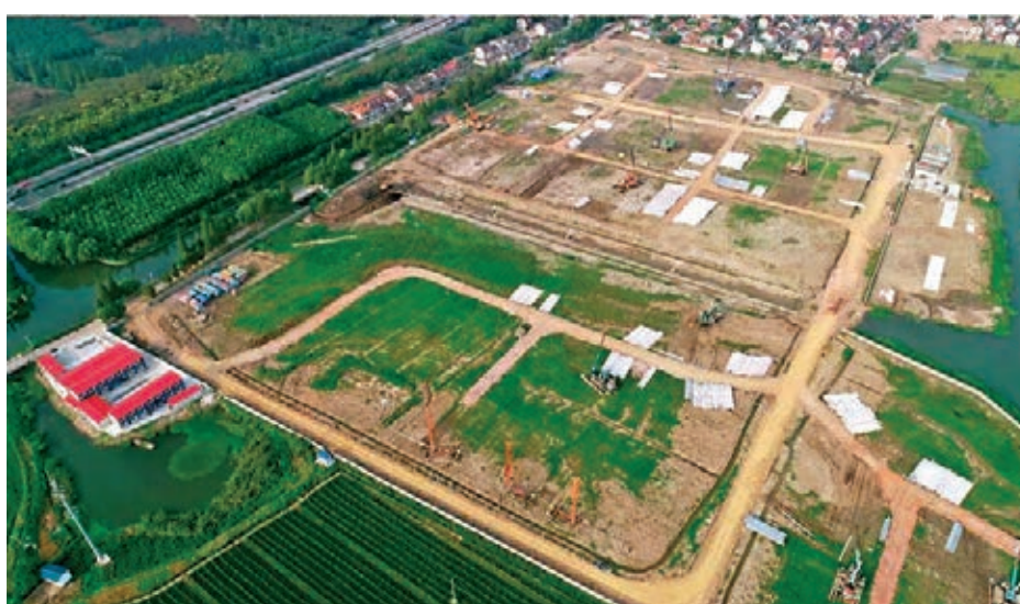
華為研發中心（金澤鎮西岑社區）動遷基地項目目前已正式開工。圖為該基地施工現場。網上圖片
