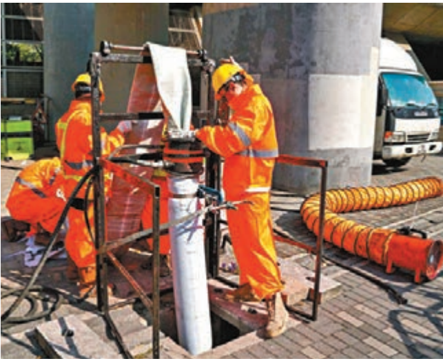
▲內套喉管法的第一步為建造一個臨時豎井。
