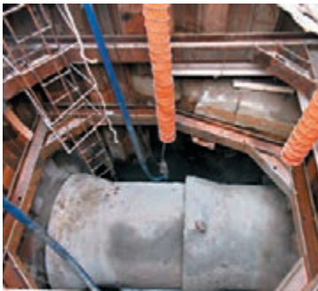
▲內套喉管法的第一步為建造一個臨時豎井。
