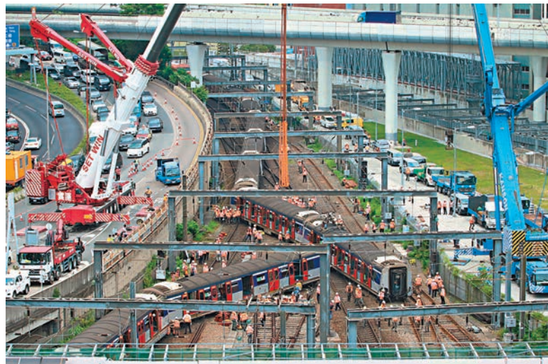
兩輛巨型吊臂車在鐵路兩側，準備吊起出軌的車廂。 香港文匯報記者 攝
