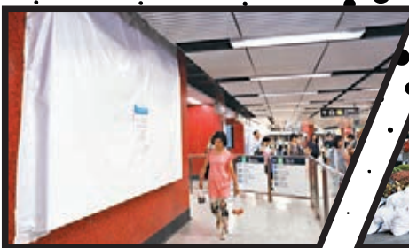
■中環站內設施亦遭破壞。
