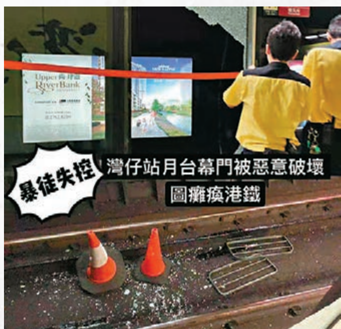
■昨日傍晚一班暴徒持疑似是路邊欄杆的硬物砸爛灣仔港鐵站的月台幕門。
