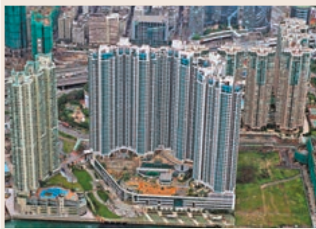
■上半年私宅項目動工以九龍區的施工伙數最多。資料圖片
