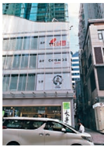
兆安廣場以每方呎約45元租出地下電梯入口至3樓樓面。
