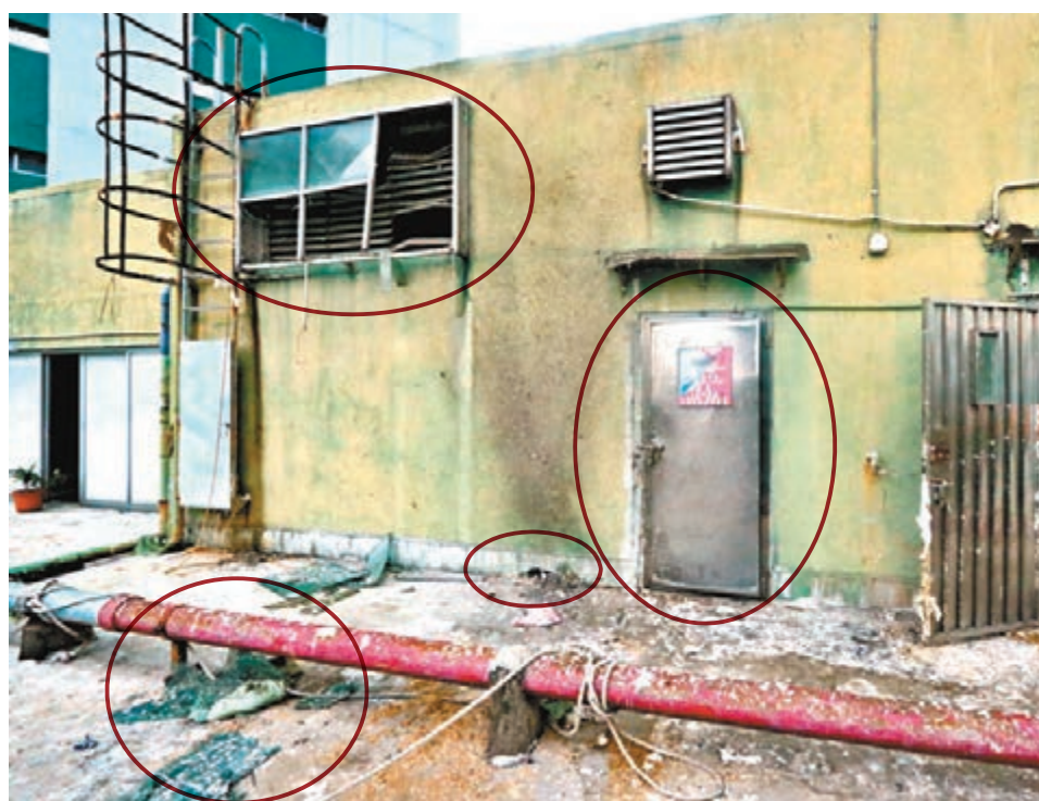
天台地面留有炸散的沙包，機房的百頁窗及加設的擋風玻璃破裂，部分支架亦告震脫移位，牆邊更被炸開一個小洞，機房門亦告彎曲變形。香港文匯報記者攝
