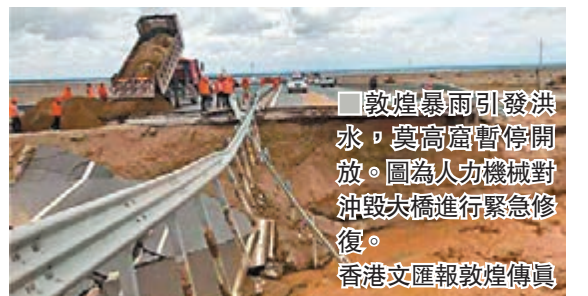
■敦煌暴雨引發洪水,莫高窟暫停開放。圖為人力機械對沖毀大橋進行緊急修復。 香港文匯報敦煌傳真
