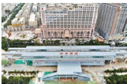
■深圳段的沙井西、福海西站、機場站和機場北站已完成靜態驗收。
