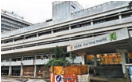
葵涌醫院重建計劃受阻。
