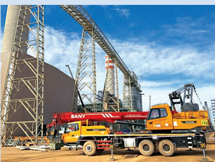
■ 中國生產的工程機械參加非洲火電站施工
