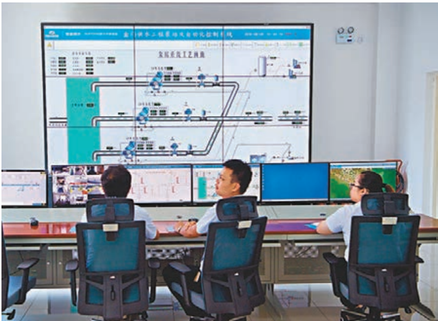
■福建方面與金門、馬祖（連江縣）已形成「小四通」初步方案。圖為此前工作人員在福建向金門供水工程泵站中控室內監視設備運行情況。資料圖片
