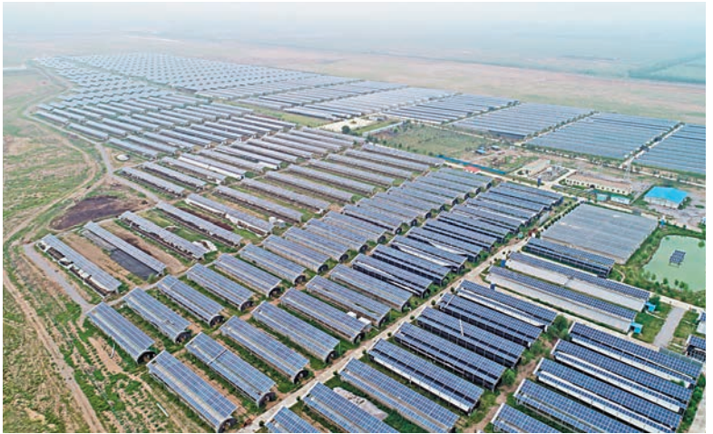
寧夏銀川市永寧縣閼閼鎮原隆村的光伏大棚。
