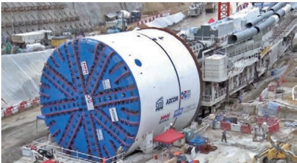
■工程團隊採用直徑達14.1米、重達3,200噸的隧道鑽挖機,是本港歷來採用最大型的土壓平衡隧道鑽挖機。 網誌圖片
