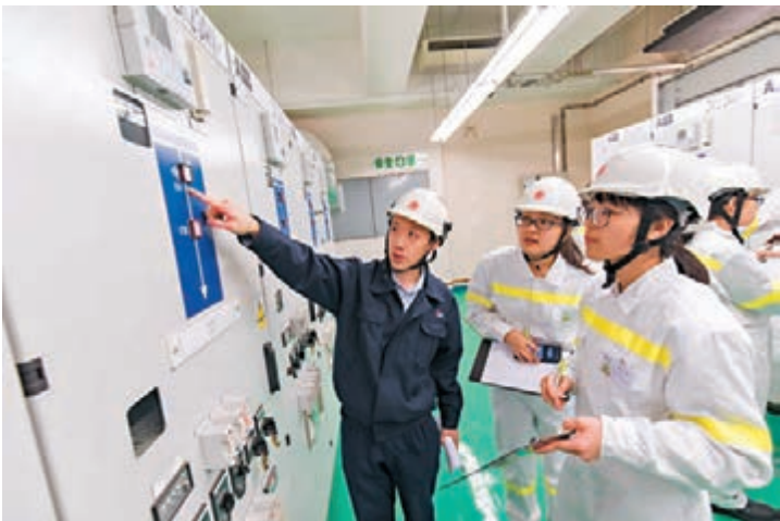
■陳又濤(右二)、劉致靜(右一)到訪馬師道變電站，協助檢查輸配電系統的設備。作者供圖
