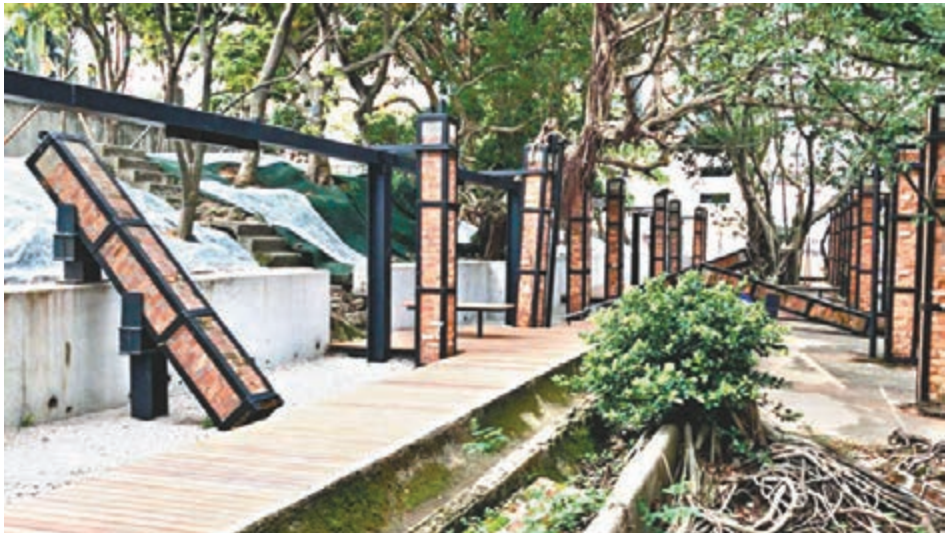
圖中的紅磚柱現時只剩下一條條紅磚柱,有些更因本身結構問題,傾斜或倒下。團隊以鋼架來穩固磚柱,並鋪設行人板道,設計成遺蹟公園的模樣。網誌圖片
