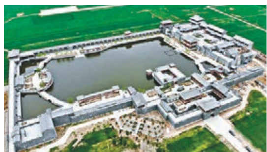
河北曲周的仿古建築群涉嫌違建。圖為被麥田包圍的仿古建築群。網上圖片
