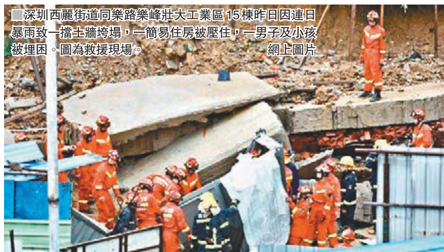
深圳西麗街道同樂路樂峰壯大工業區15棟昨日因連日暴雨致一擋土牆垮塌,一簡易住房被壓住,一男子及小孩被埋困。圖為救援現場。網上圖片
