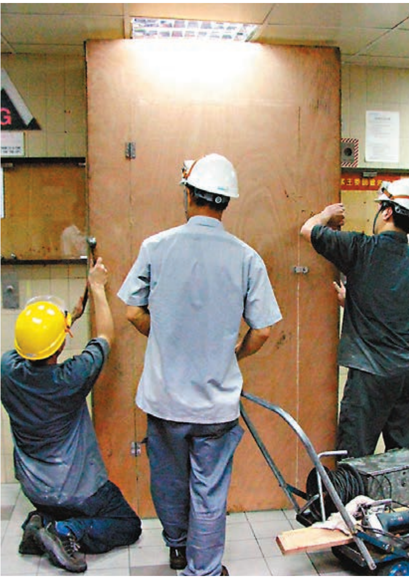
電梯維修承辦商檢修升降機。
