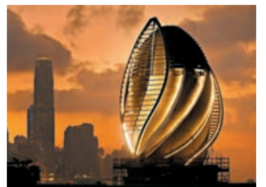
■東面通風大樓系統原來已關閉多時。
