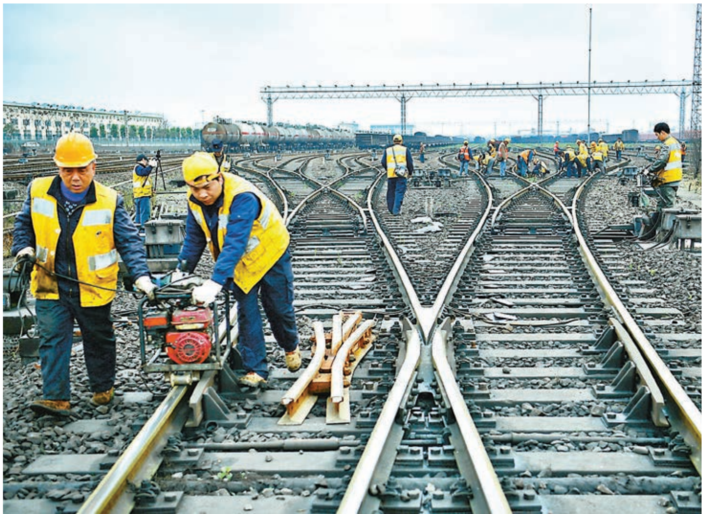
楊潔篪受訪時表示，「一帶一路」已完成了夯基壘台、立柱架梁的階段，轉入落地生根、開花結果的全面推進階段，面臨着重大合作機遇。圖為四川成都工務段上百名職工放棄休假加緊施工作業，確保中歐班列（成都）多拉快跑。資料圖片
