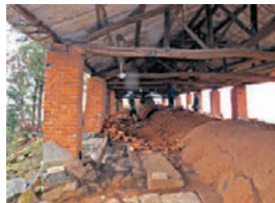
■龍窯依坡而建，窯身半埋於地下，由窯頭、窯室、窯尾三部分組成。圖為龍窯。香港文匯報記者趙臣 攝
