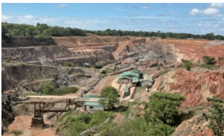
■Chibuluma的露天礦坑 - 用於皇冠支柱採礦
