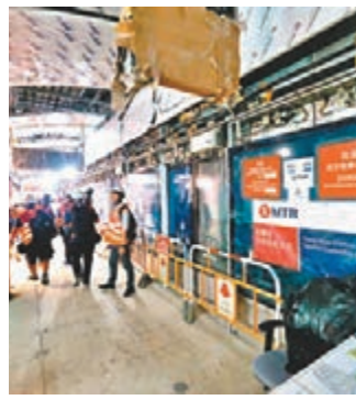
港鐵沙中線紅磡站地盤。資料圖片
