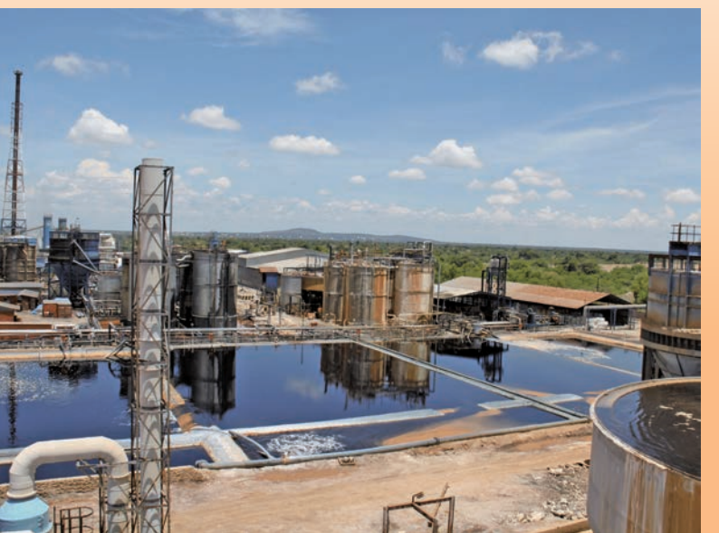
■Ruashi的浸煉池
