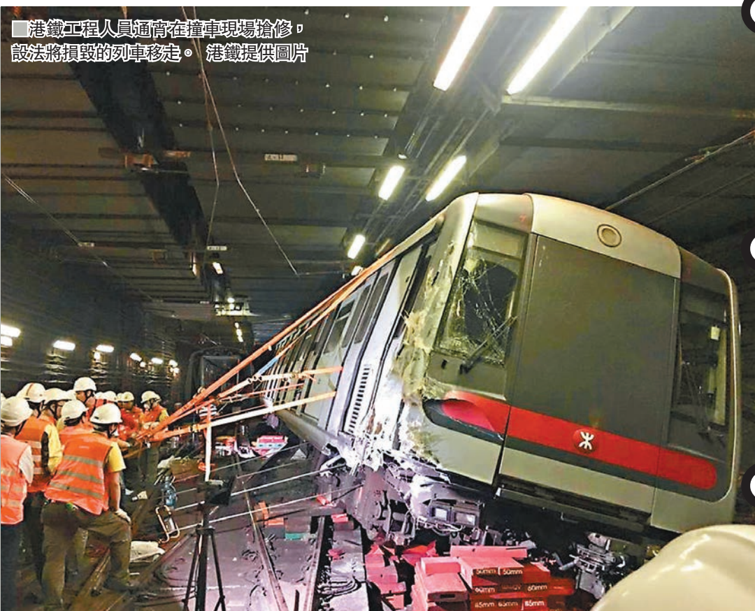
■昨晚約11時，港鐵工程人員已成功將偏離的頭卡放回路軌，稍後會安排將其移離正線。港鐵提供圖片
