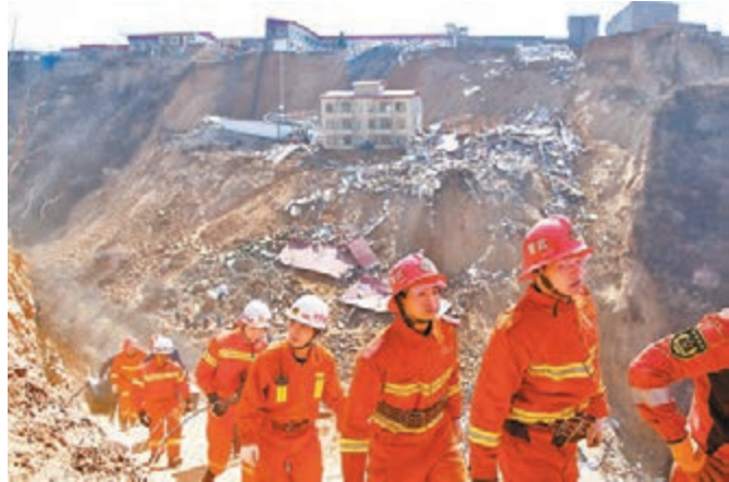
救援人員正在搜救房屋垮塌被困人員。中新社
