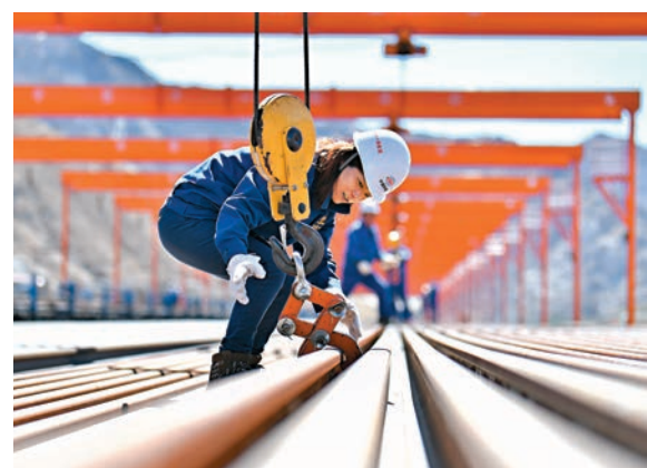
圖為工人將鋼軌吊裝至鋼軌推送車上。
