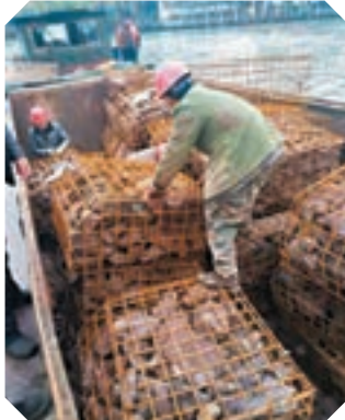
■杭州城管局近日完成對拱宸橋進行水下加固。圖為工人將石塊裝入鋼筋石籠。網上圖片
