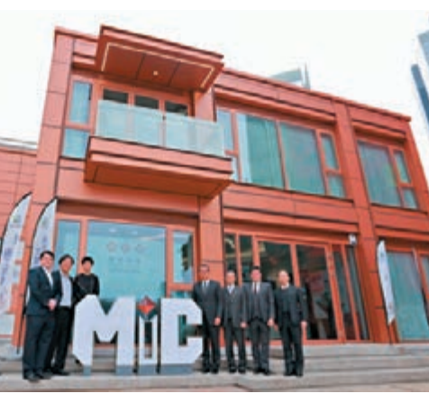
旨在展示「組裝合成」建築法的「組建城」坐落於九龍灣零碳天地。網誌圖片
