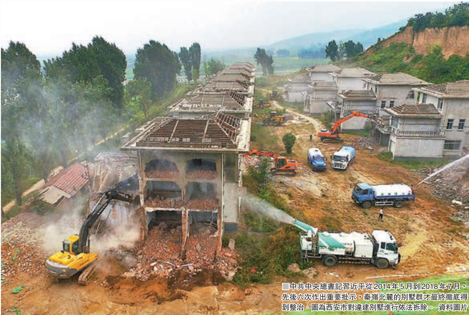
■去年7月31日起，秦嶺北麓違建別墅查清一棟拆除一棟，然後復綠復耕。 網上圖片
