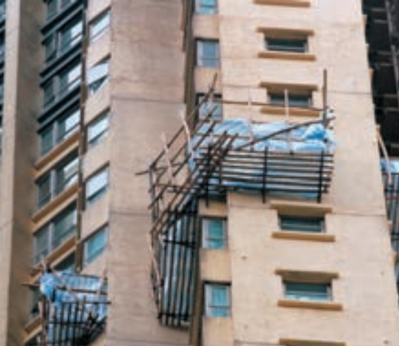
■大廈高處有單位外牆搭有懸空式棚架進行裝修工程。
