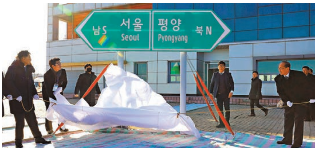
韓國統一部稱施工儀式只是表達信守承諾。 法新社
