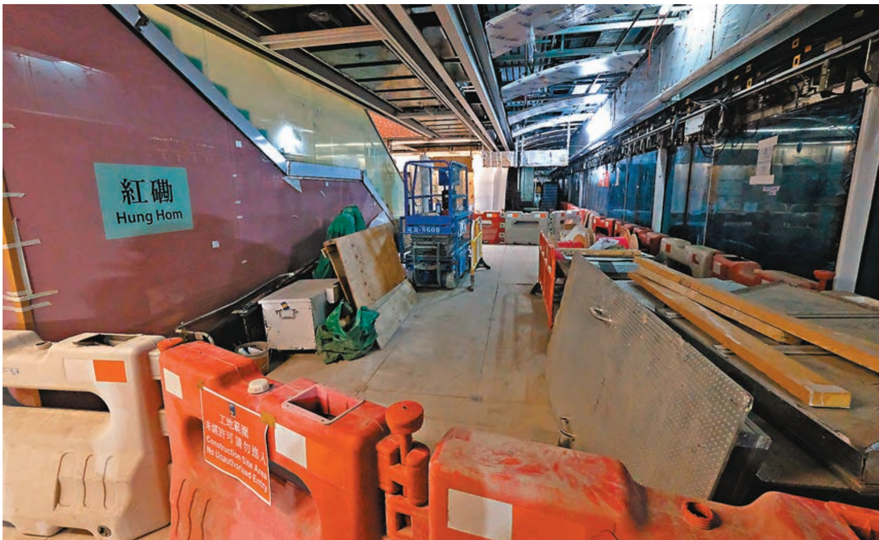
■港鐵紅磡站地盤。
